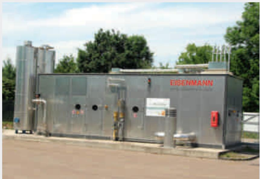
Fig. 2 Biogasaufbereitungsanlage nach dem Membranverfahren der Firma Eisenmann auf der Biopower-Anlage in Pratteln
